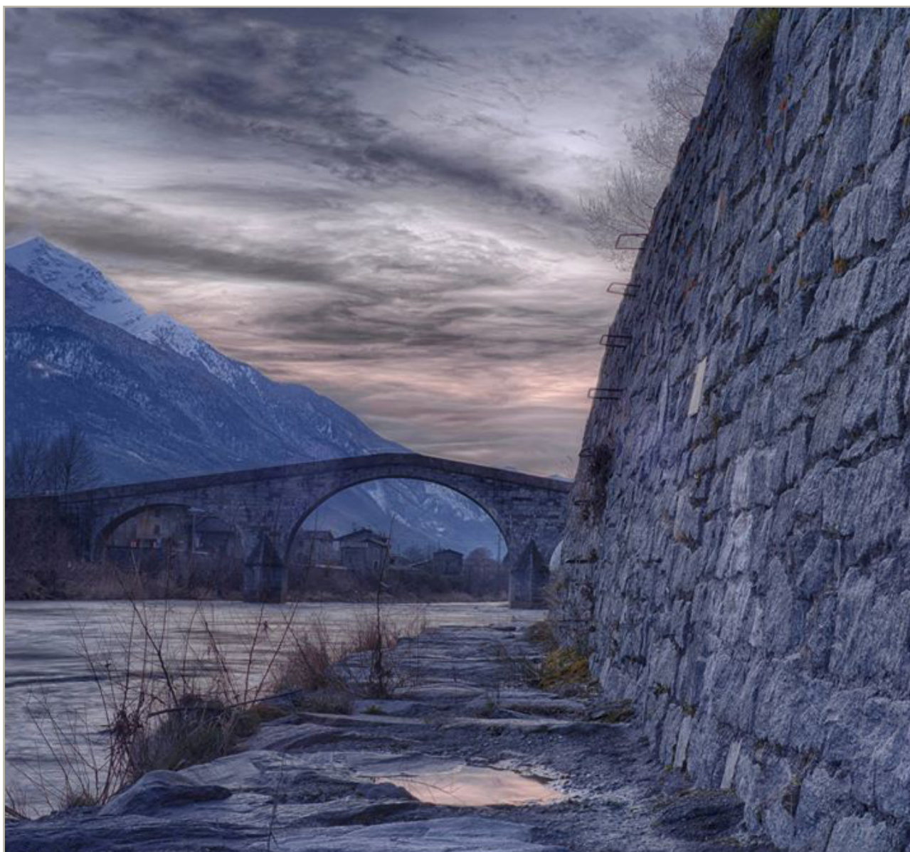
Il ponte di Ganda sull'Adda di Morbegno (foto: A. Sertorelli)
